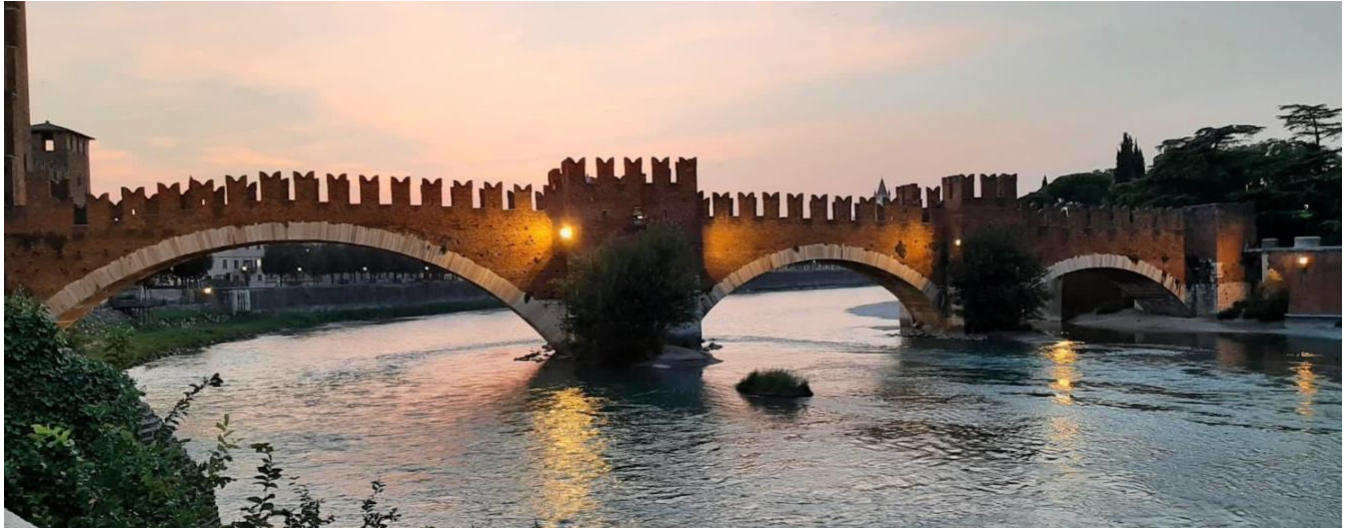
Abb. 3: Mögliche Brückenkonstruktion - Scaligero-Brücke ist eine typische Bogenbrücke, deren Brückenpfeiler als Wehrtürme fungieren (Foto: Dorothe Radelof)
